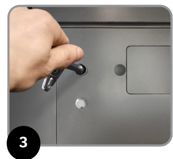
ขั้นตอนที่ 3 (Step 3) หมุนกุญแจตามเข็มนาฬิกา Turn the triangular key clockwise.
